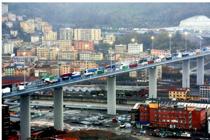
▲ Il ponte Genova San Giorgio
