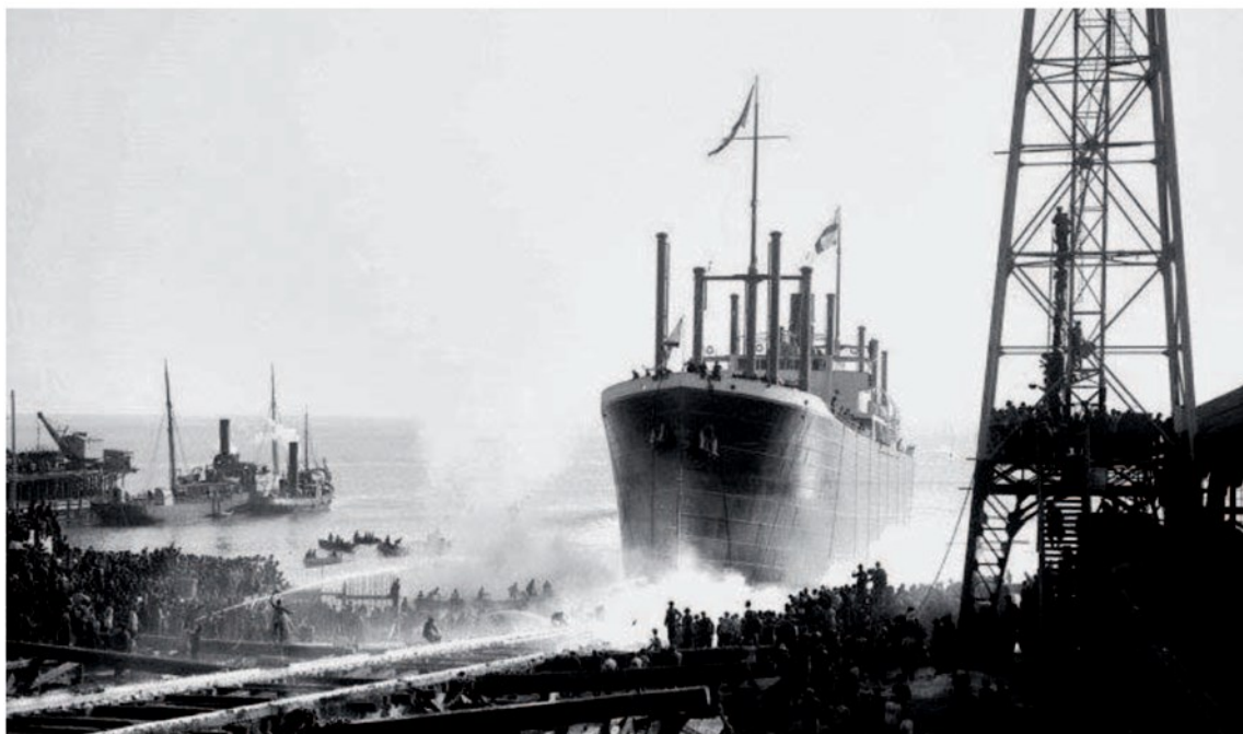
▲ Il varo Un'immagine iconica del passato industriale di Genova con un varo tradizionale in cantiere
