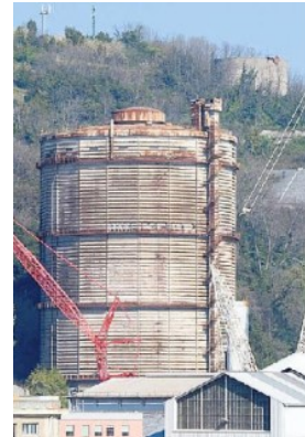
Il gasometro prima della demolizione bloccata dalla Soprintendenza
