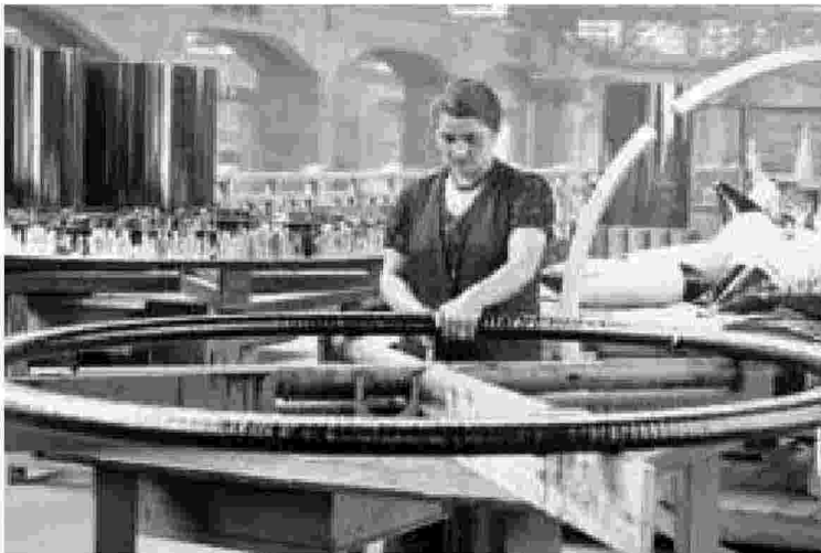
Lavorazione degli avvolgimenti per trasformatori, 1936
