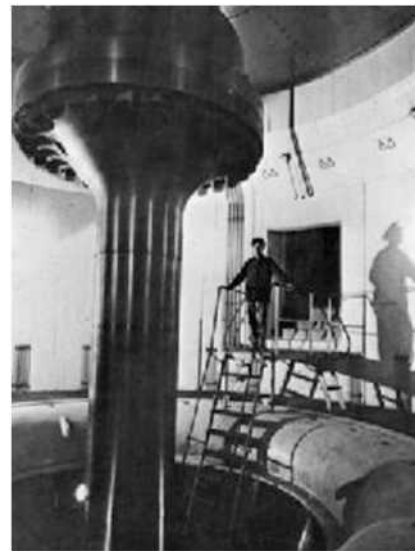
TURBINA costruita a Rivarolo, 1957
